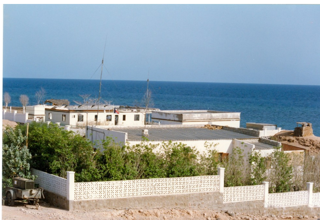
Cantonnement d'Obock (© G. Cabry)
